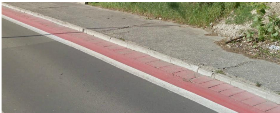
Obrázok 51 Cyklistický pruh vedený cez odvodňovací žľab (príklad realizácie)
