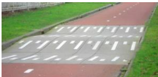
Obrázok 55 Cyklistický spomaľovač (príklad realizácie Holandsko)
