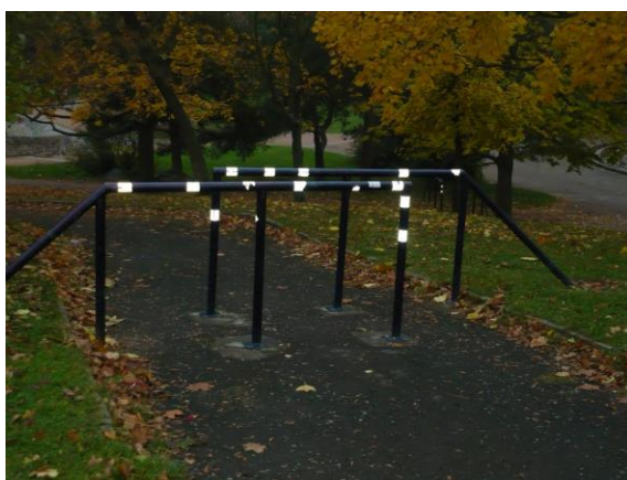
Obrázok 56 Profilová zábrana (príklad realizácie)
