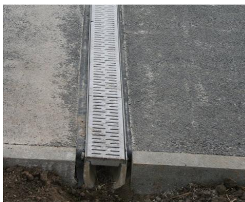
Obrázok 52 Priečne odvodnenie CYK (príklad realizácie)
