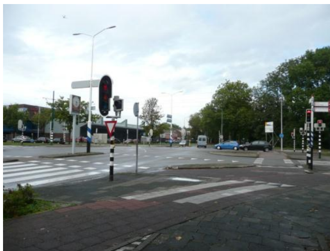
Obrázok č. 19: križovatka 2 rozvádzacích ciest, kde sa zriadila plná križovatka so semaformi a stĺpmi na ochranu cyklistov pred odbočujúcimi autami
