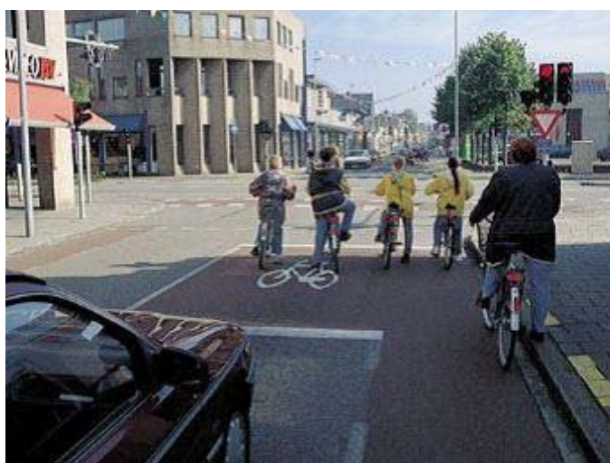
Obrázok č. 21: cyklo box na križovatke vo Vlielande, Holandsko
