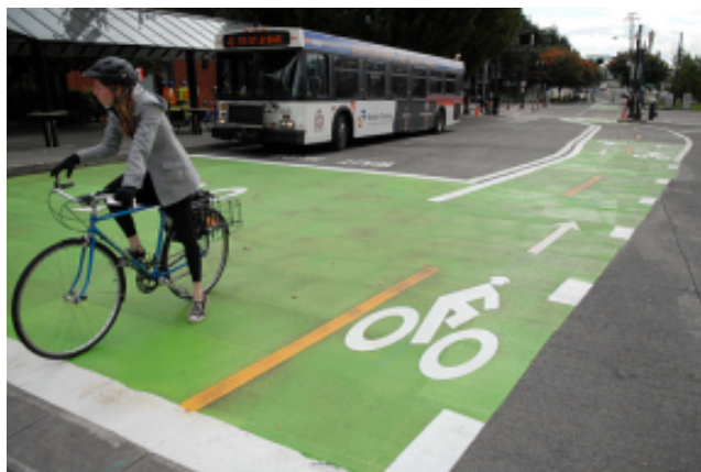
Obrázok č. 26: zelená farba povrchu cyklo pruhu v Portlande (žltá čiara je použitá na oddelenie smerov pohybu cyklistov v oboch smeroch)
