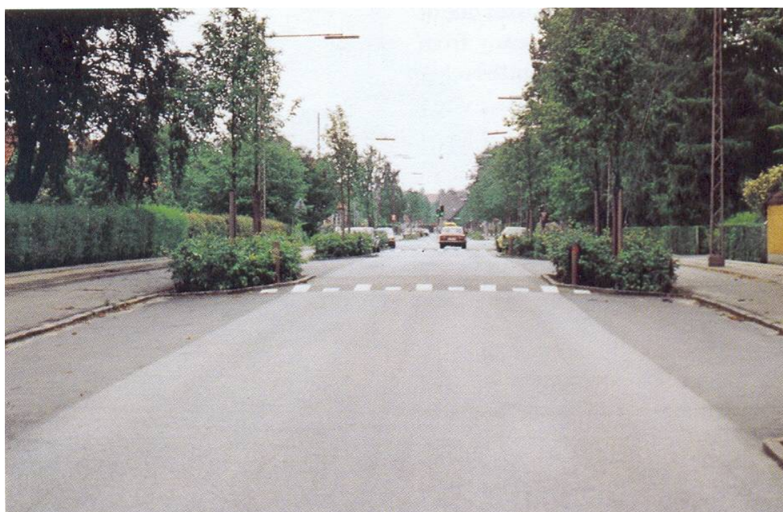
Obr 7.34 Posun a zúženie jazdného pruhu vysunutou plochou
