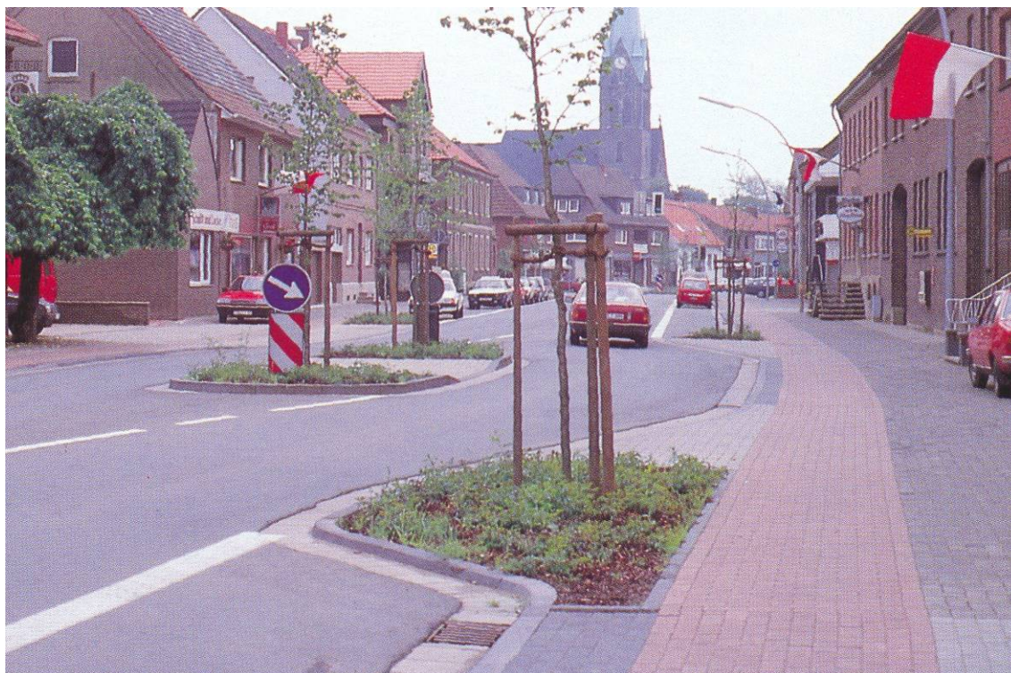
Obr. 7.39 Dlhý priečný prah s posunom jazdného pruhu
