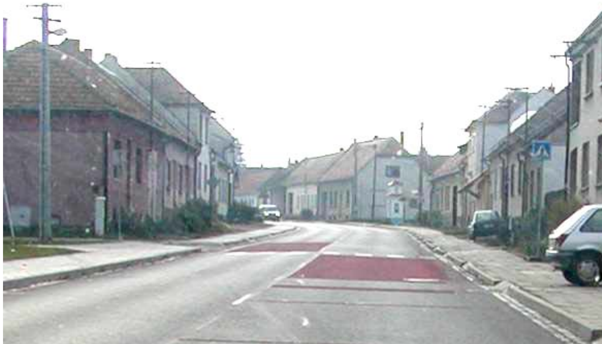
Obr. 7.30 Zmena povrchu vozovky
