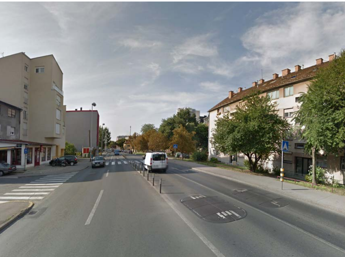
Obr. 27 ▲ Vankúše použité na hlavnom ťahu cez mesto – na ceste 2. triedy. Vďaka úzkemu tvaru je vhodné aplikovať ich na cesty obsluhované autobusmi. 📍 Selska cesta 139, Záhreb, HR. Foto: Google StreetView
