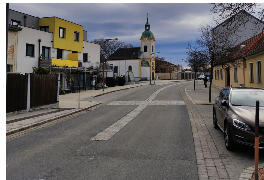
Obrázok 22 Implementovanie iných materiálov do vozovky za účelom spomalenia vozidiel na cestnom prietahu v obci Klein Neusiedl (AT). Zdroj: Rozsár, 2022
