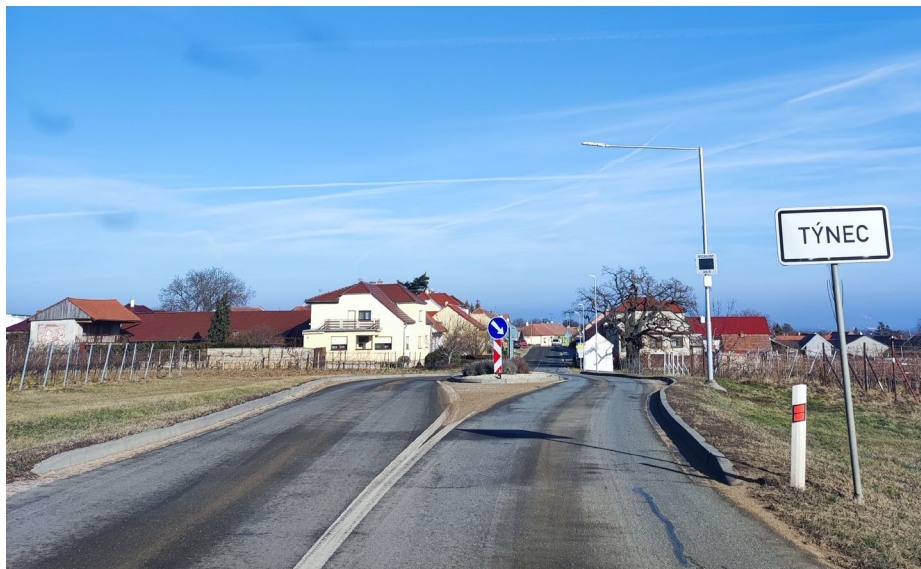
Obrázok 20 Vyosenie vjazdu a výjazdu z obce Týnec (ČR) zabezpečujúce primeranú rýchlosť vozidiel. Zdroj: Rozsár, 2022.
