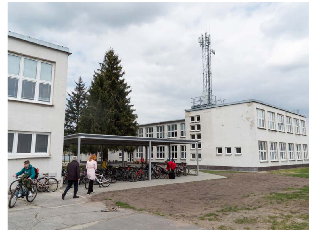
Obr. 24.: ▲ Prístrešok pre bicykle so zelenou strechou ako súčasť zelených riešení z grantových zdrojov pre Základnú školu v Borskom Mikuláši.
