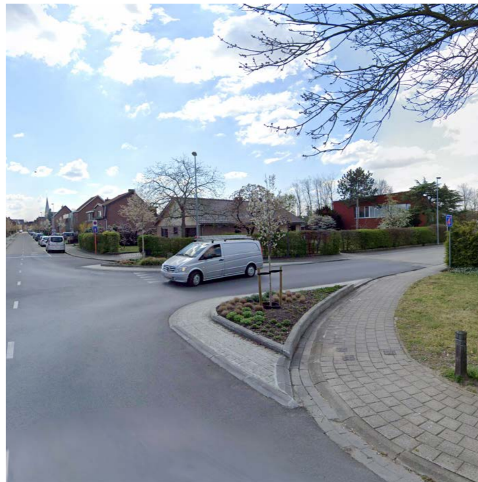
Obr. 12.: ▲ Dodatočné zmenšenie rádiusov križovatky, v tomto prípade stavebnými úpravami (križovatka Poverstraat x Zellaerstraat, Bonheiden, Belgicko). Foto: Google Streetview
