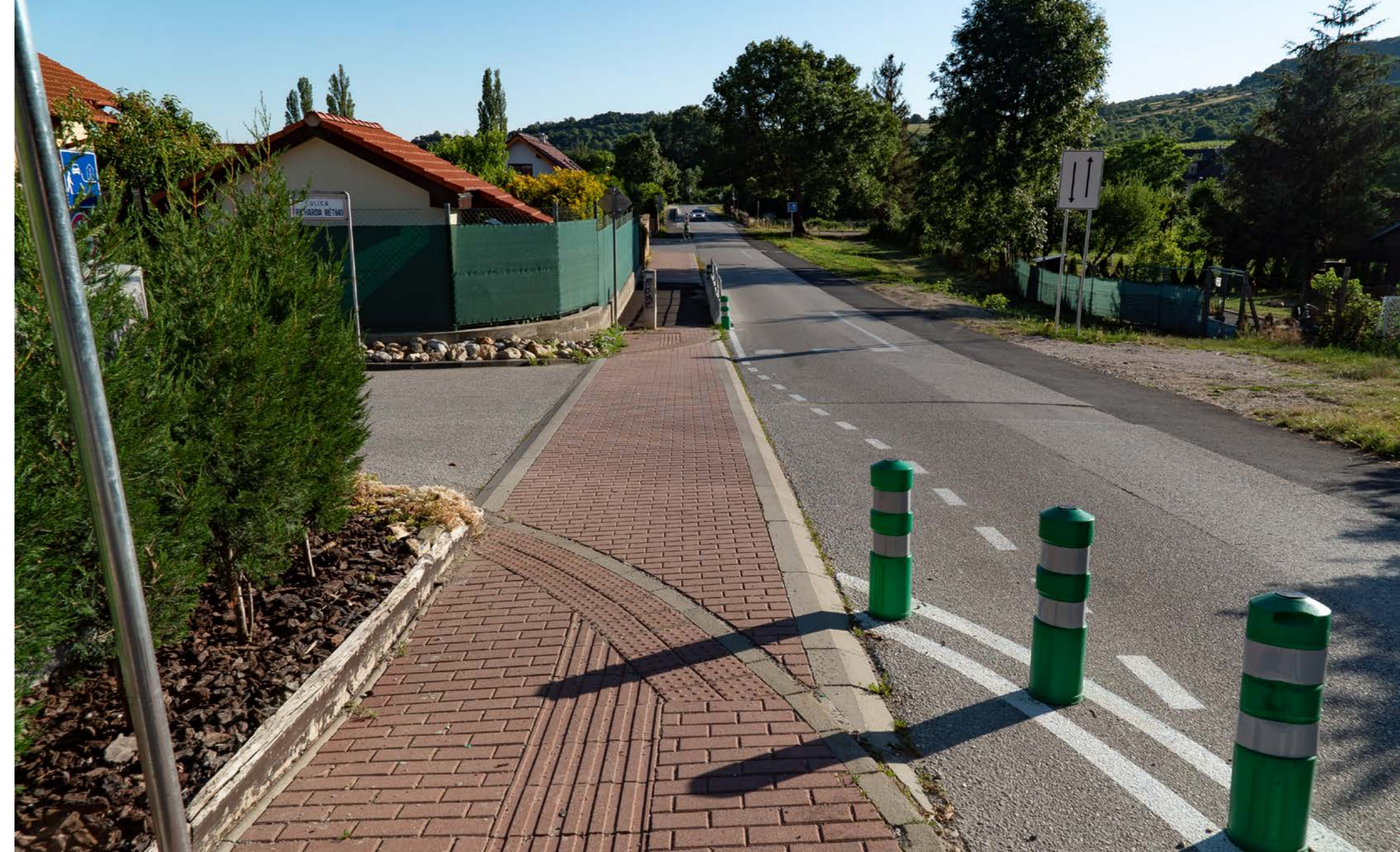
Obr. 22.: ▲ Priebežný chodník s jasne označeným povrchom pre chodcov zároveň opticky oddeluje zónu 30 od hlavnej rýchlej cesty (Križna ul., Pezinok).
