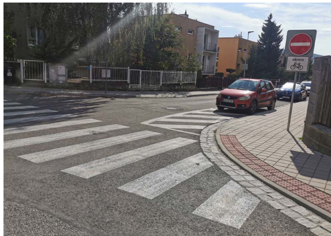
Obr. 8.: ▲ Doplnenie značenia, tzv. dopravných tieňov na zabezpečenie rozhľadových kužeľov v blízkosti priechodov (Zlatohorská ul., Bratislava). Foto: V. Chládeková.
