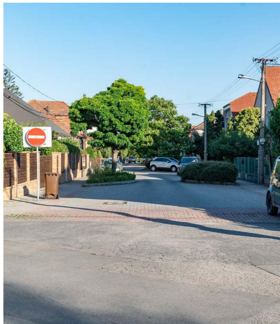
Obr. 34.: ▲ Dizajn obytnej ulice, ktorý vďaka prelomenej priamej línii jazdy a spomaľovacím prahom na vstupe fyzicky zabraňuje rýchlej jazde (Šafárikova ul., Pezinok).
