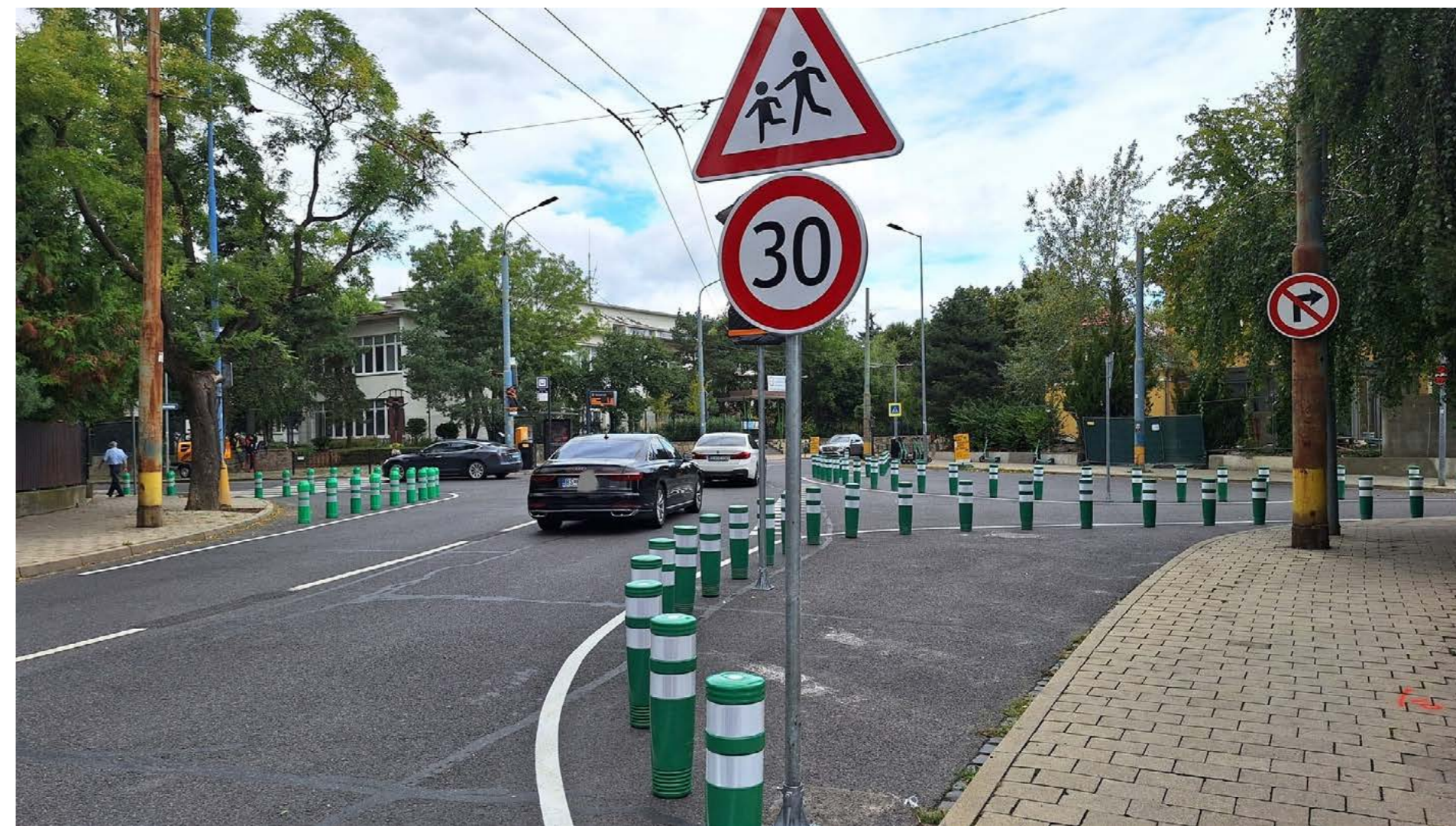
Obr. 11.: ▲ Aby autá neparkovali na dopravných ťieňoch je nutné často použiť stavebné alebo dočasné prvky, ktoré im v tom zamedzia. Cieľom je zvýšiť prehľadnosť v križovatke (příklad je z Mudroňovej ul., Bratislava). Foto: Bratislavské noviny
